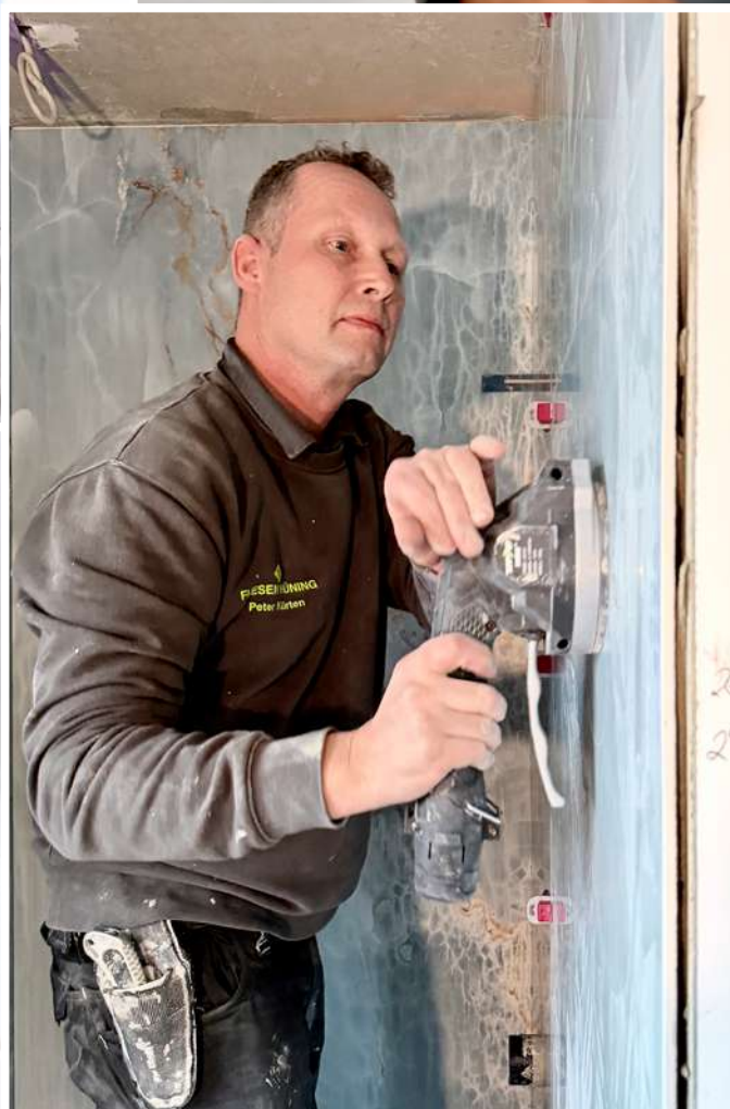
Millimeterarbeit im XXL-Format: Pascal, Peter und Björn bändigen eine 1,20 x 2,80 Meter große Keramikplatte.
